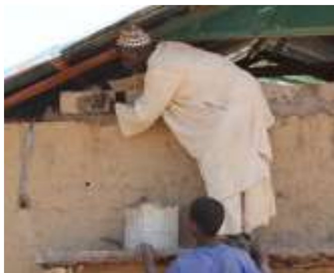
Bouchage d'avant-toits ouverts en Gambie. Crédit : Steve Lindsay
